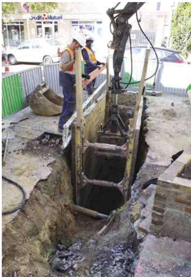
Travaux d'assainissement à Villeneuve-Saint-Georges
