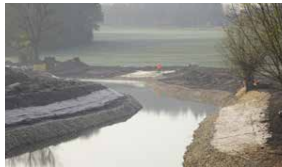
L'Yerres à Evry-Grégy-sur-Yerres durant les travaux
