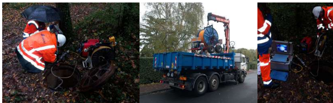
Moyens spécifiques d'inspection et de curage mis en oeuvre
