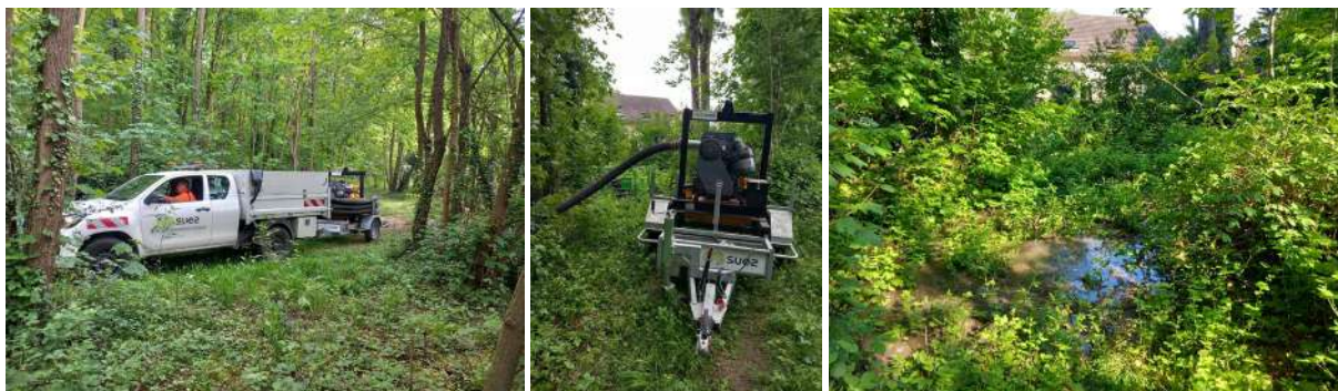
Moyens mis en œuvre dans le cadre de l'obstruction du réseau de transport DN 200 à Santeny
